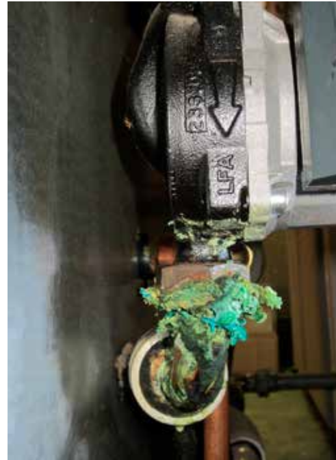
Uitbloeiing van inhibitor aan een flens.
