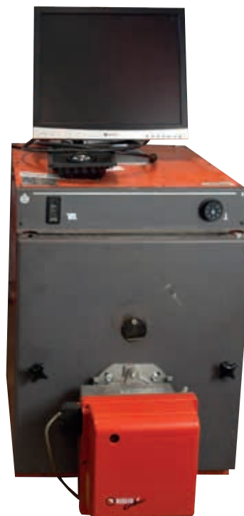
De ACV-lagetemperatuurketel uit 1996 en de Riello-brander uit 2006 hadden geen aanpassingen nodig.
